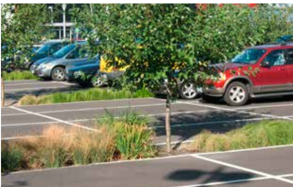
RIGOLE DE DRAINAGE BIOLOGIQUE DU RUISSELLEMENT VENANT DU STATIONNEMENT.
