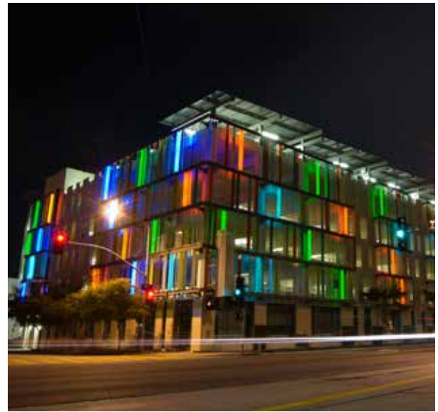
STRUCTURE DE STATIONNEMENT.
