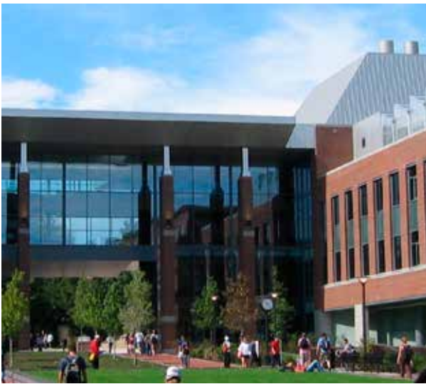
ENVIRONNEMENT CONSTRUIT DU CAMPUS.
